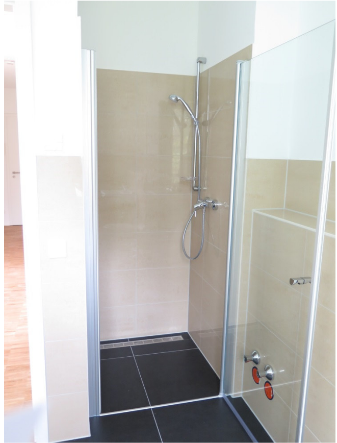
Glasduschtrennwand mit 1 cm Abkantung unter der geschlossenen Duschtüre Abbildung 9
