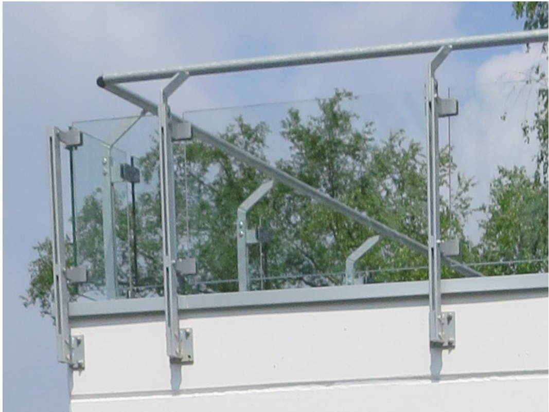
Balkongeländer Stahl feuerverzinkt mit Glasausfachung Abbildung 21
