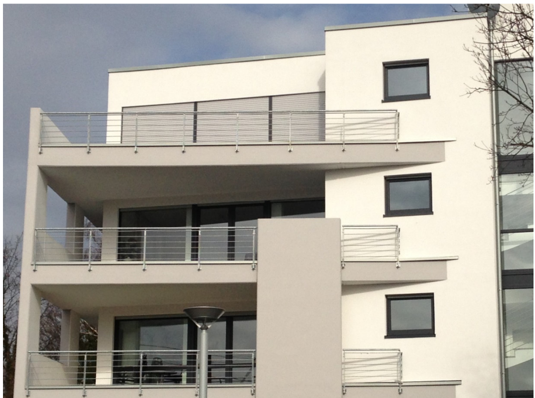
Balkongeländer Stahl feuerverzinkt mit waagerechten Füllstäben Abbildung 20
