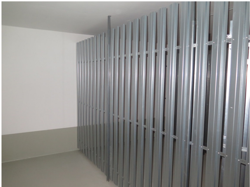
Systemwände aus verzinkten Stahlprofilen Abbildung 26
