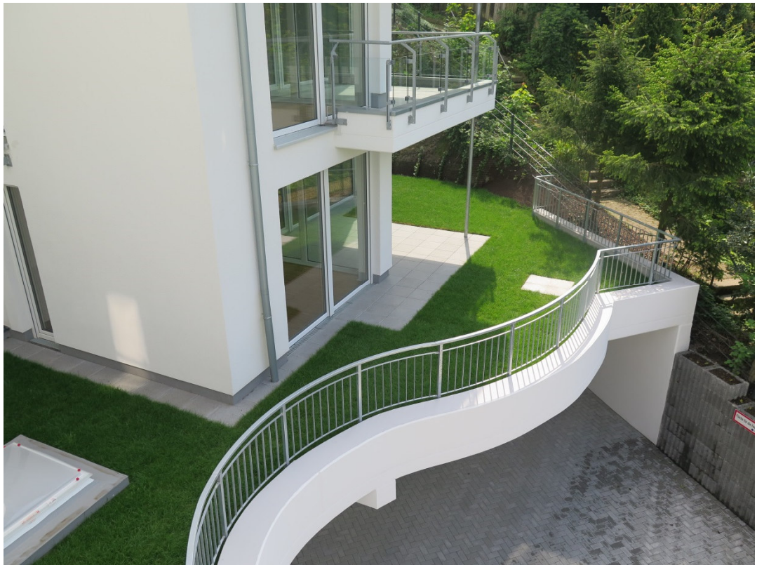
Balkongeländer Stahl feuerverzinkt mit senkrechten Füllstäben Abbildung 19
