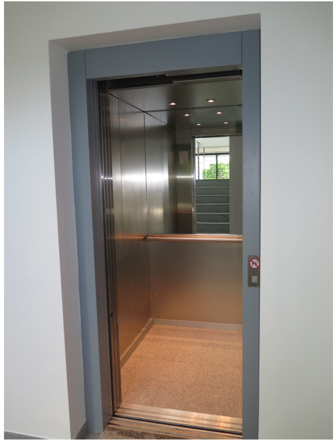
Aufzugkabine mit Edelstahlbekleidung und Spiegel Abbildung 25
