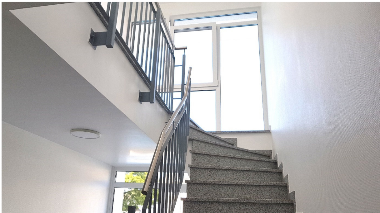
Treppenhaus mit zweimal viertel gewendelter Treppe und großen Fensterflächen Abbildung 32
