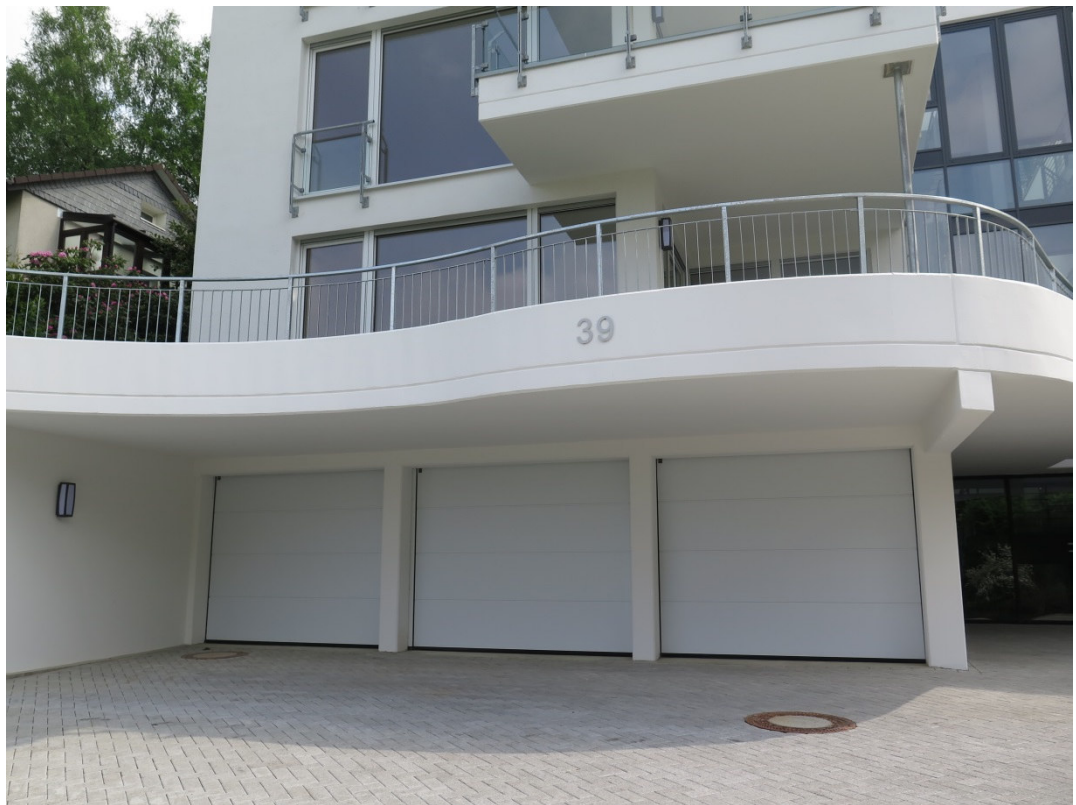
Sektionalgaragentore wärmegeklämmt horizontal mit weißer Aluminiumoberfläche Abbildung 24
