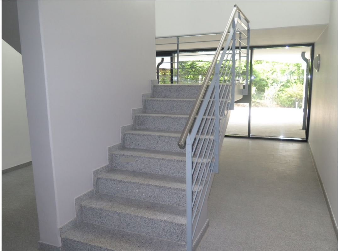
Bodenbelag aus Granit, Treppengeländer Stahl grau lackiert mit Edelstahlhandlauf Abbildung 1
