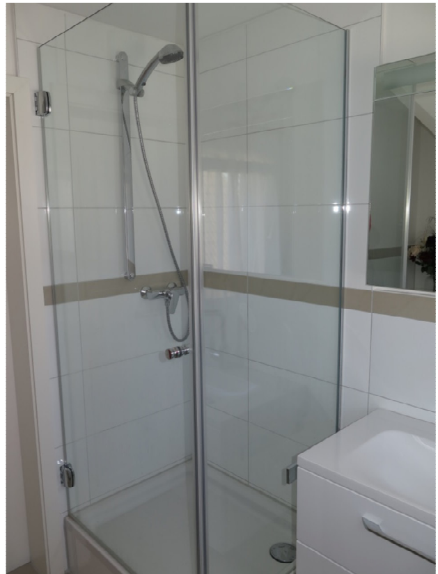
Sonderwunsch z. B. Duschtrennwand aus Ganzglas mit verchromten Beschlägen Abbildung 27
