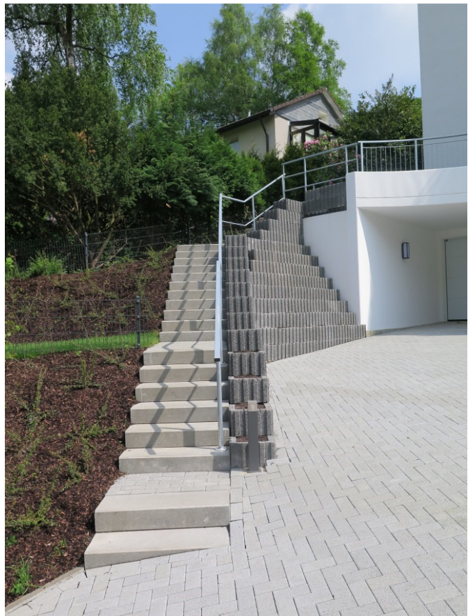
Betonfertigteilstufen, sickertfähiges Betonpflaster, Böschungs-Pflanzsteine rechteckig Abbildung 22
