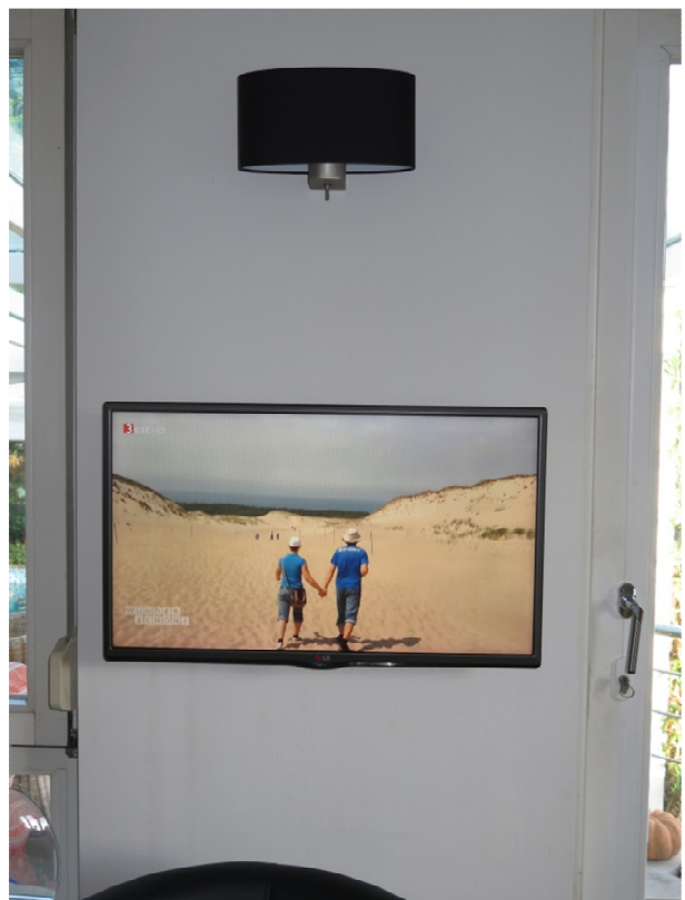
Sonderwunsch z. B. versteckte Fernsehverkabelung über Leerrohr in der Wand Abbildung 30
