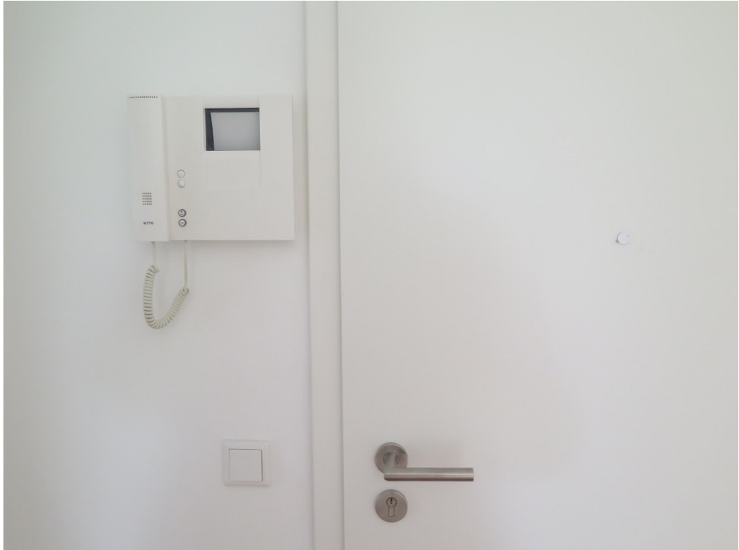
Türsprechanlage mit Monitor, Ritto TwinBus Video Objektsystem, Innentüre weiß lackiert Abbildung 3
